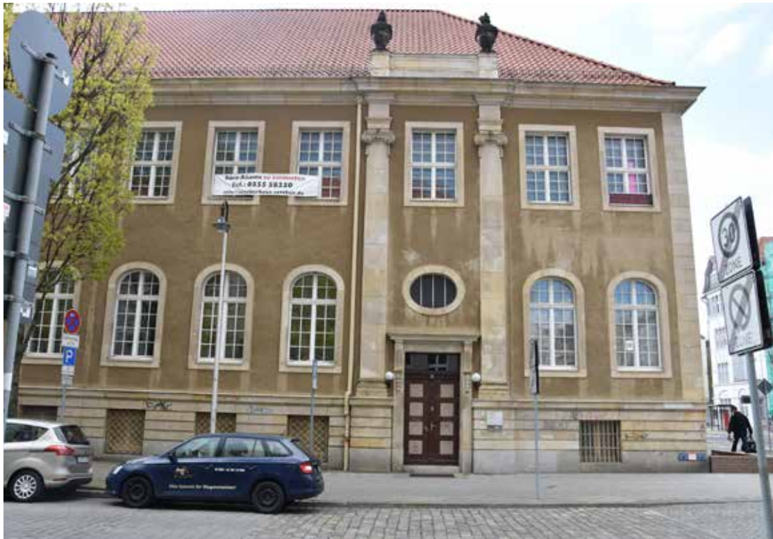
Schulungsgebäude in Cottbus mit dispo-Tf-Fahrzeug
